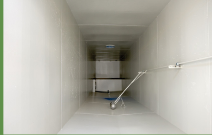
Vue intérieure du réservoir « Frac Tank »
